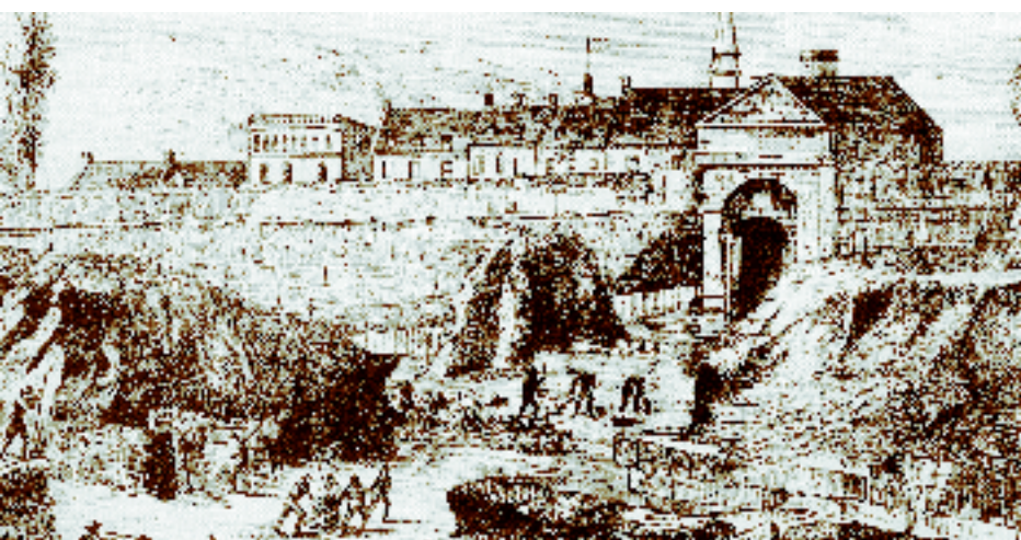
TRAVAUX DE DÉMOLITION ENTREPRIS PAR LA MUNICIPALITÉ DEVANT LA PORTE SAINT-LOUIS, 1871. L'Opinion publique , 14 septembre 1871.
