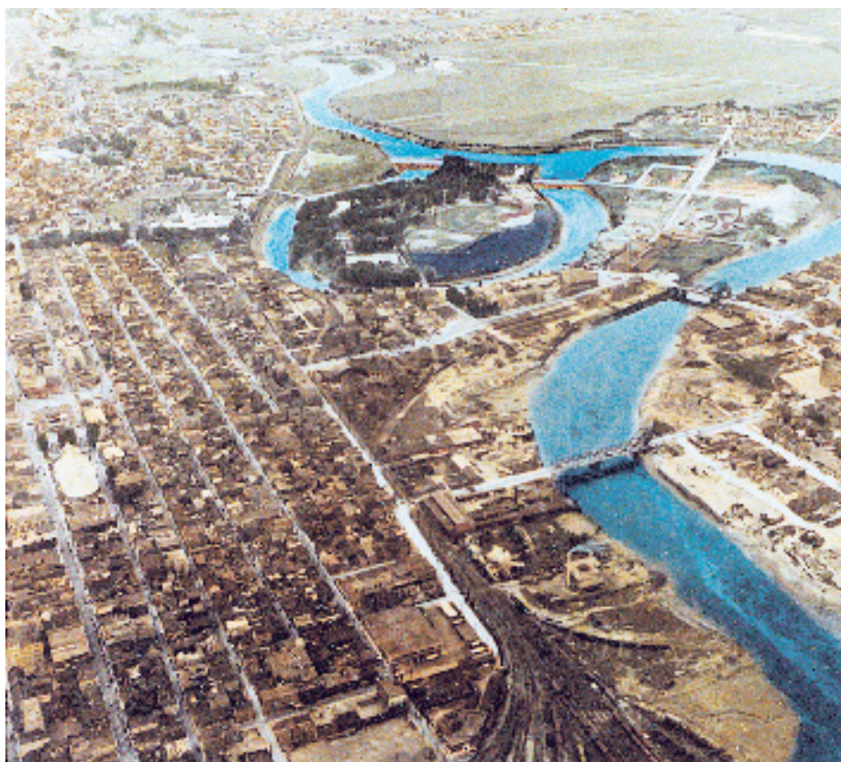
ASSÈCHEMENT DU MÉANDRE DE LA RIVIÈRE SAINT-CHARLES.
