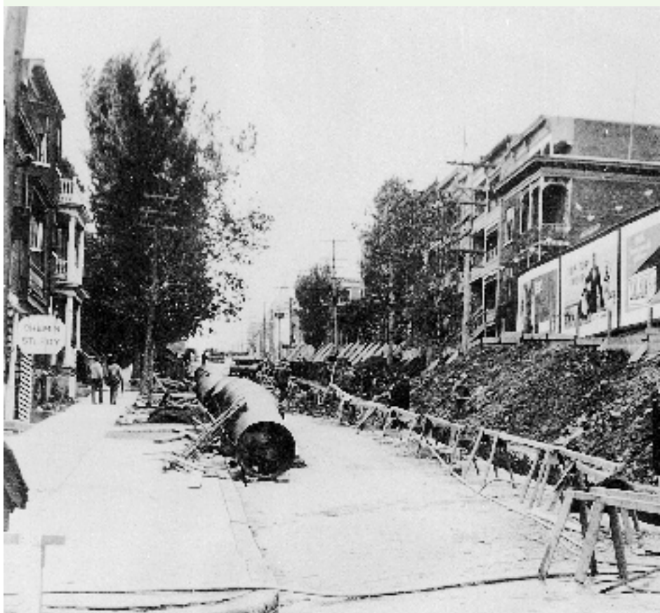
TRAVAUX D[É] L'AQUEDUC, QUARTIER MONTCALM-SAINTE-SACREMENT, VERS 1940.
