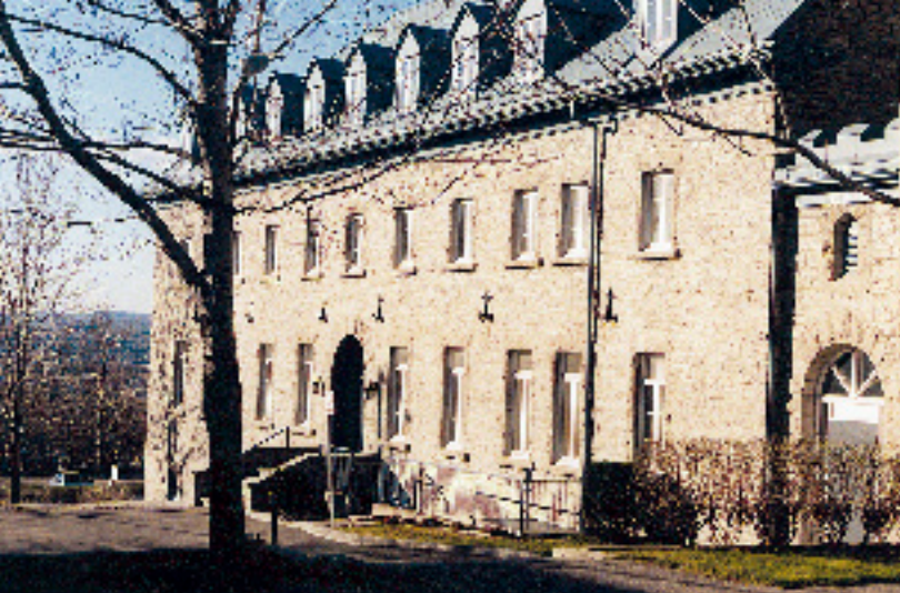
L'ANCIEN MONASTÈRE DES FRANCISCAINS, RÉNOVÉ PAR LA SOMHAC EN 1984-1985. Photographie Claude Bélanger.
