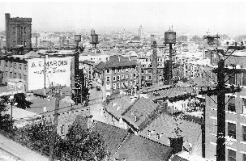
VUE DES USINES ET DES HABITATIONS OUVRIÈRES DU QUARTIER SAINT-ROCH, 1928. Archives de la Ville de Québec, Thaddée Lebel, négatif n° 17614.
