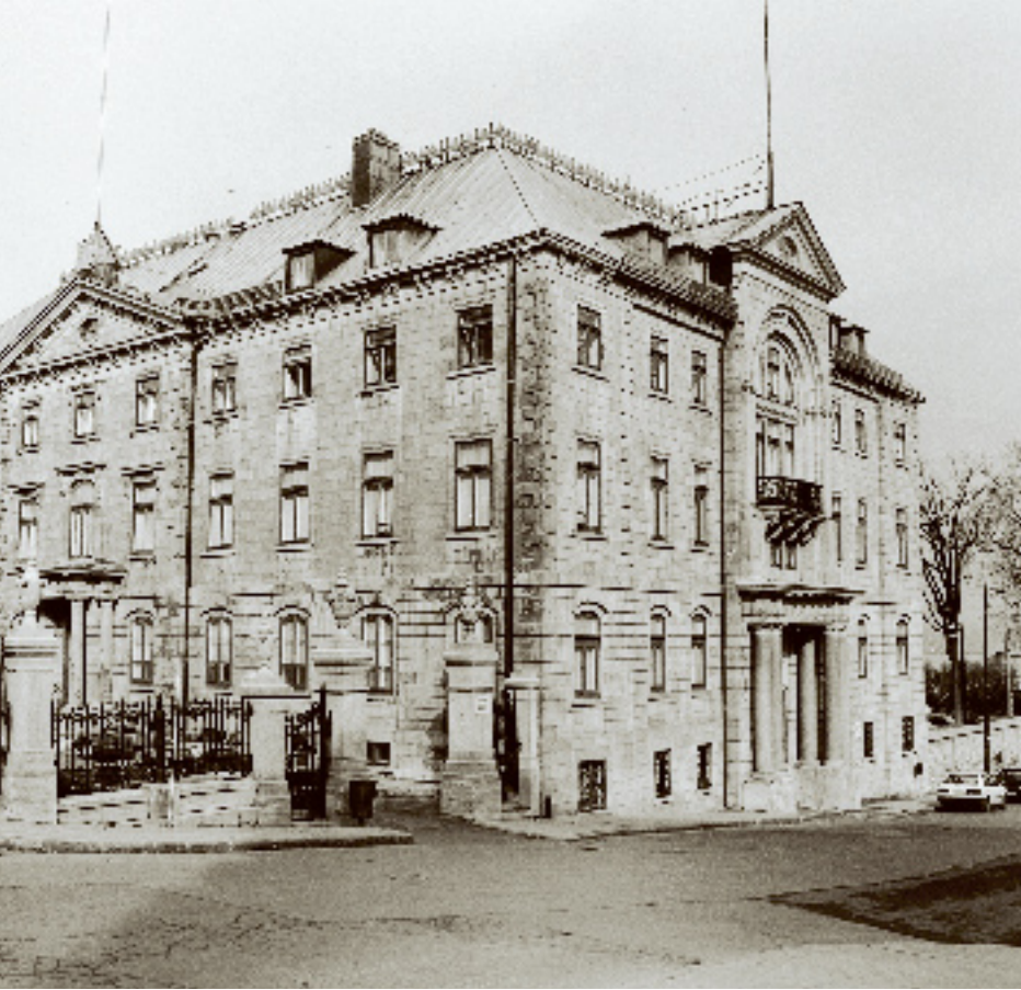
L'ARCHEVÊCHÉ DE QUÉBEC, LIEU DE TOUTES LES RENCONTRES IMPORTANTES DE L'ÉPISCOPAT DU QUÉBEC ET DU CANADA AU COURS DE LA PREMIÈRE MOITIÉ DU SIÈCLE.
