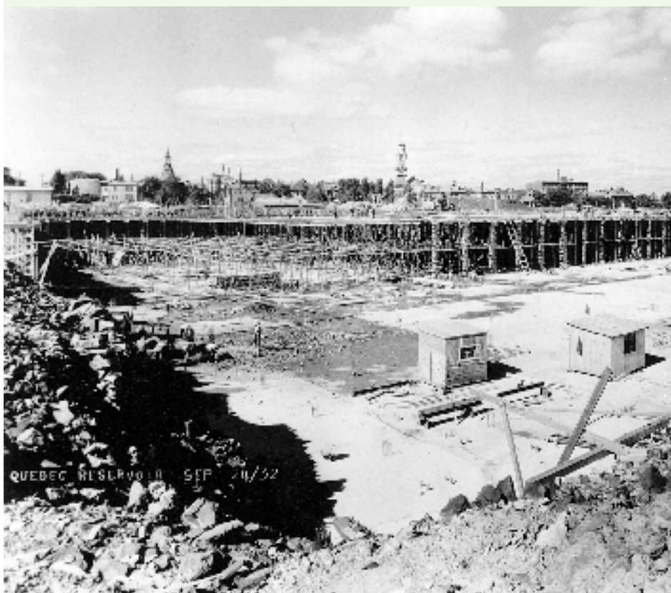
LE « LAC SOUS LES PLAINES », CONSTRUCTION DU RÉSERVOIR D'EAU SOUTERRAIN DE LA VILLE SUR LES PLAINES D'ABRAHAM, 1932.
