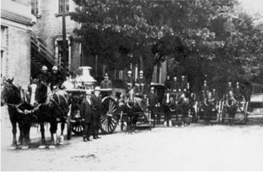
Un service municipal essentiel. Trois-Rivières se dote de nouveaux équipements contre l'incendie (c.1910). Archives photographiques du Nouvelliste .
