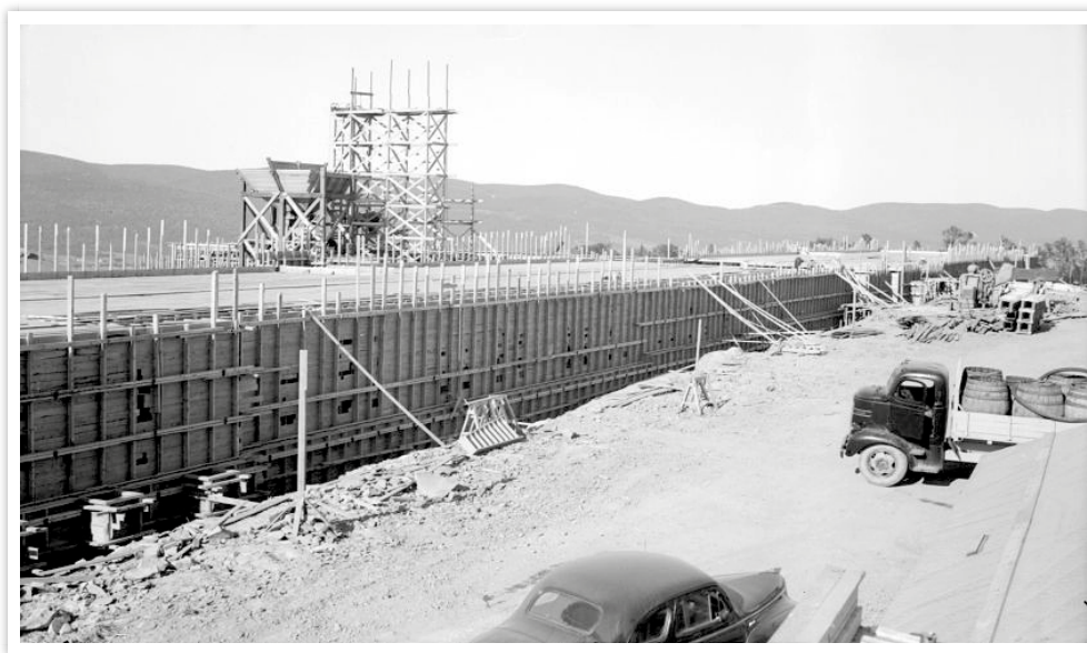
FIGURE 11 SANATORIUM EN CONSTRUCTION À GASPÉ, 1946 E.L. Désilets. BANQ-QC, E6,S7,SS1,P33398.
