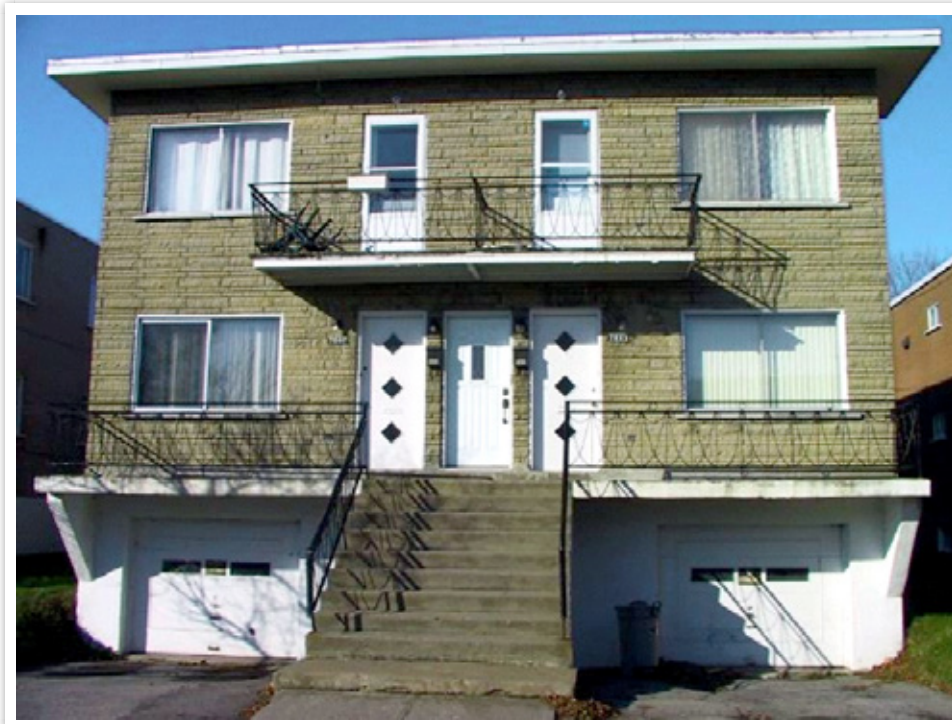
FIGURE 7 UN DUPLEX À LASALLE DANS L'ÎLE DE MONTRÉAL CONSTRUIT DANS LES ANNÉES 1960 ET QUI INTÈGRE DES GARAGES POUR LOGER LES AUTOMOBILES. Photo: Claire Poitras, 2004.
